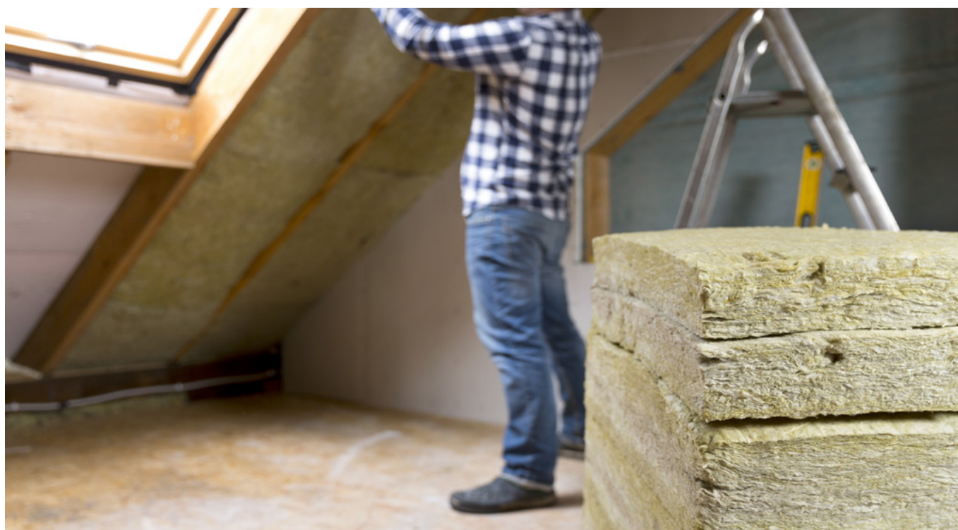
Fig. 11: la laine minérale, un isolant thermique universel et pourtant extrêmement efficace. Il est léger, facile à travailler et incombustible.
